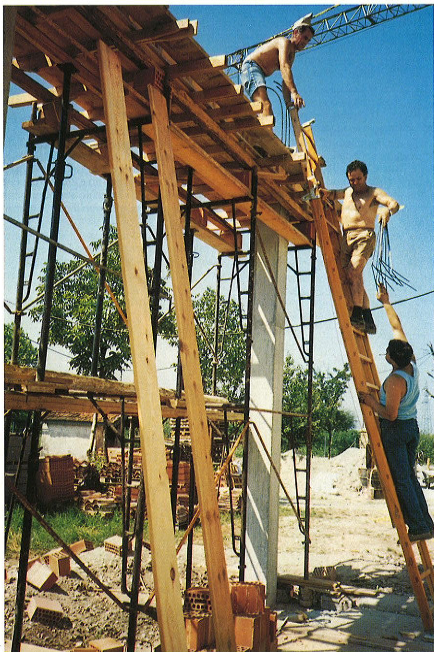
Tre volontari mentre armano le strutture dell'architrave del porticato
