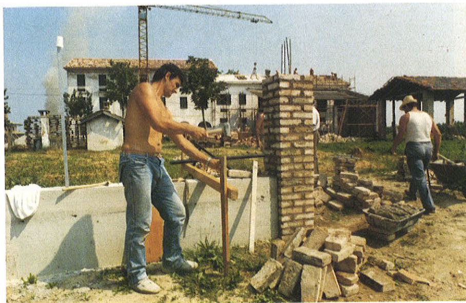
Il capocantiere Sergio Zavarise, mentre sta lavorando alla recinzione della proprietà della casa.
