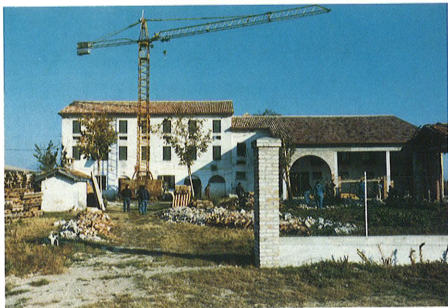
Il nostro cantiere al secondo anno di lavoro: è già stato rifatto il tetto e la recinzione.
