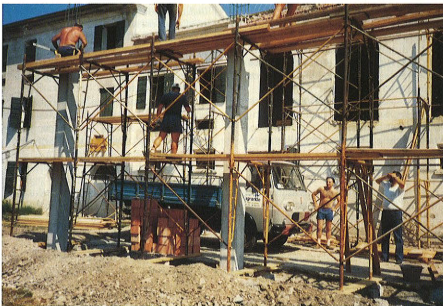
Ultimi lavori per la copertura della casa.
