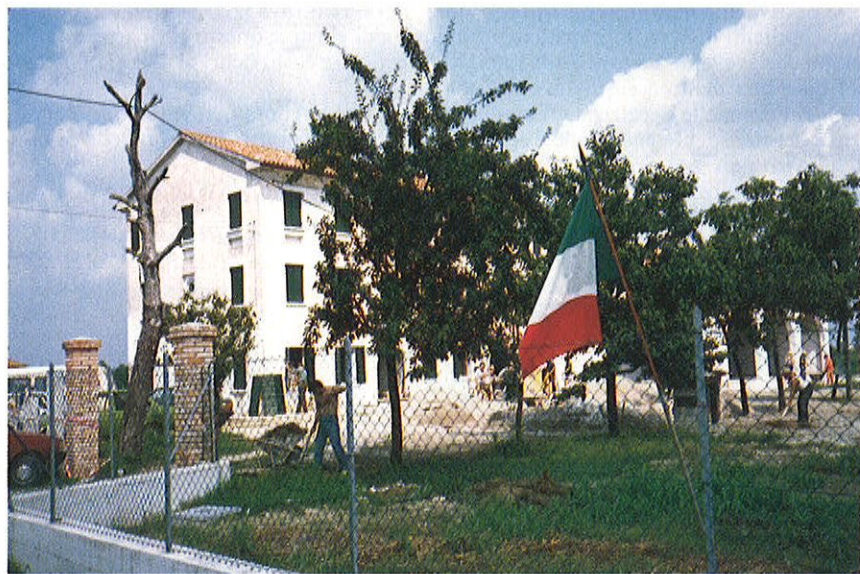
La casa di Fontanelle a lavori di ristrutturazione quasi ultimati.
