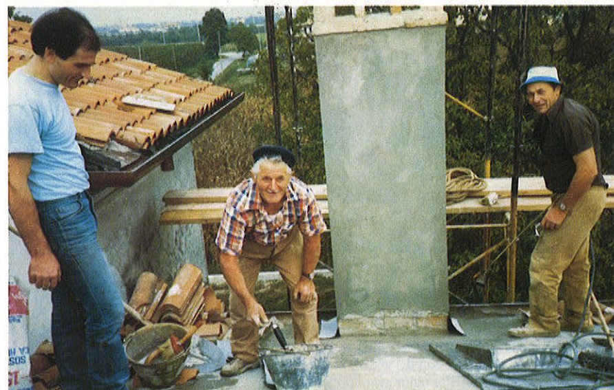
Tre volontari mentre eseguono gli ultimi lavori ad un camino della casa.
