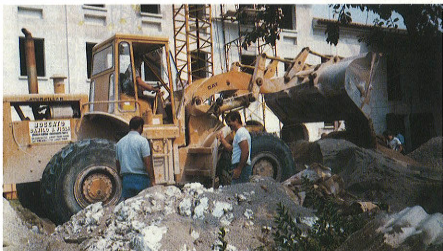
Viene impiegata la ruspa per l'escavazione necessaria per la posa dei pozzetti.
